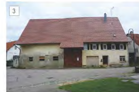
Defizitäre Bausubstanz in der Stiftstraße ...
