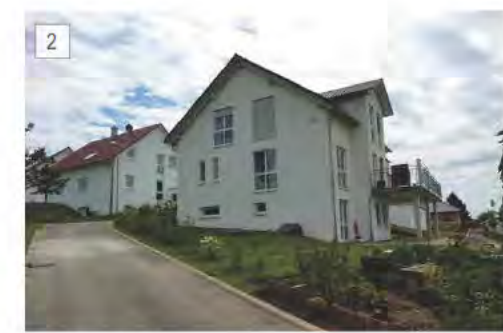
Am Berg - Neubau
